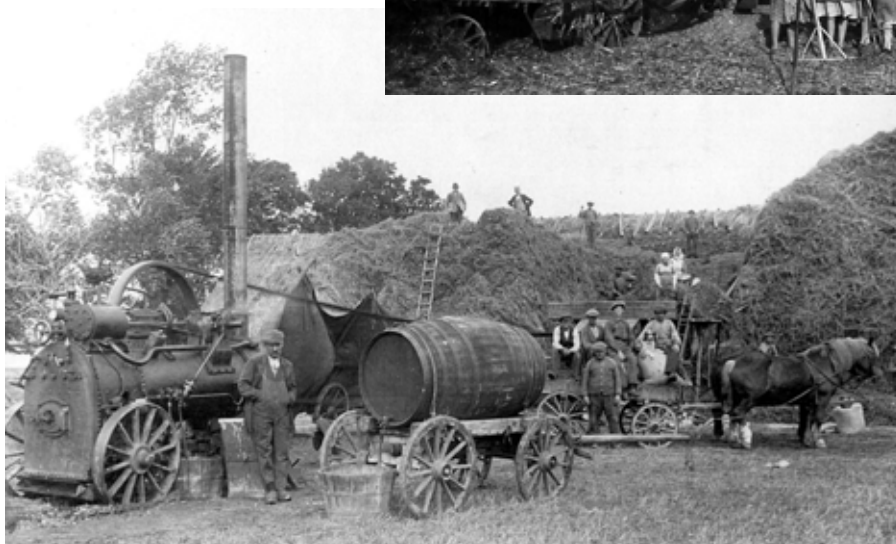
Tröskning med lokomobil på Lindegård, Anderslöv nr 6, 1915
